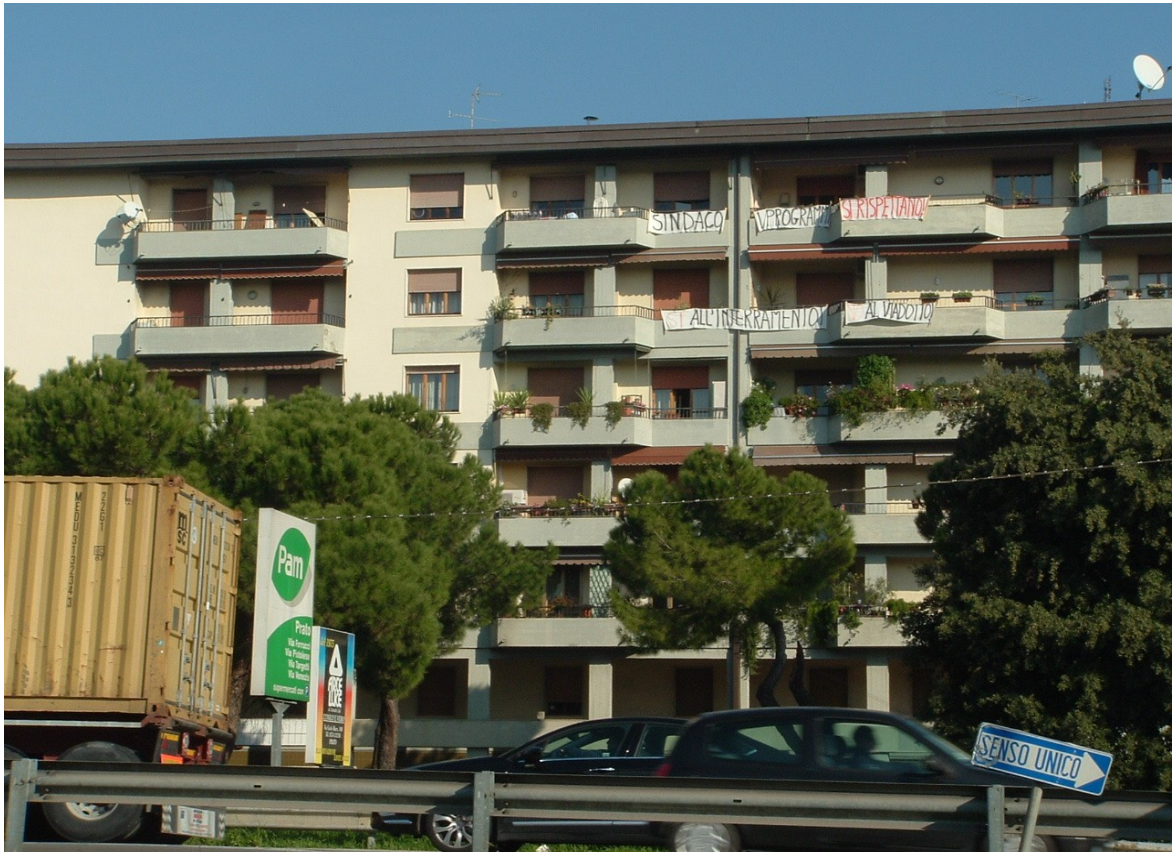
Condominio Via Padova lato declassata – Vista sui balconi dove sono state fatte le misure
