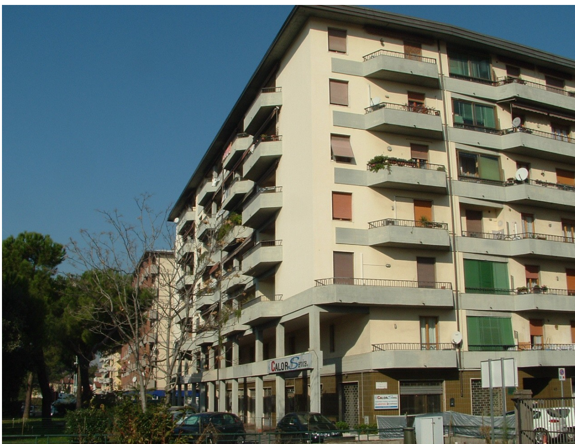
Condominio Via Padova lato Via Ferrara
