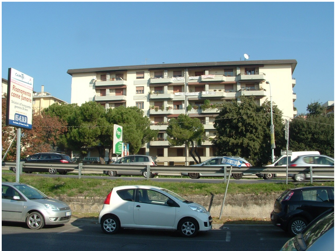
Condominio Via Padova – Vista da Via Panziera
