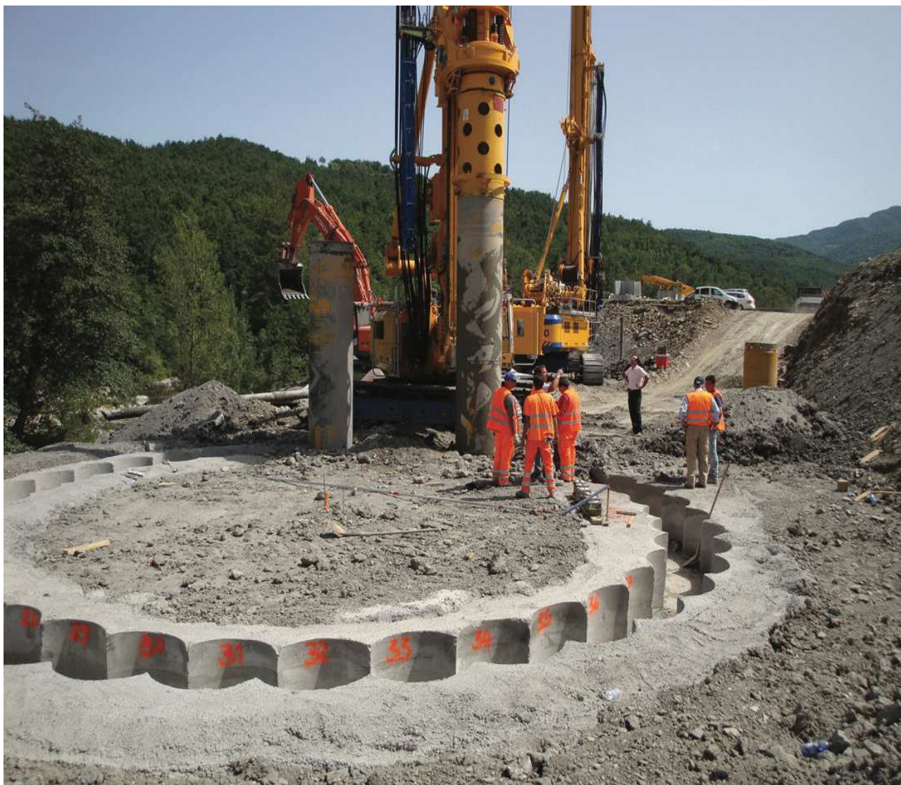
Figura 2-1 Macchina per la realizzazione di pali secanti
