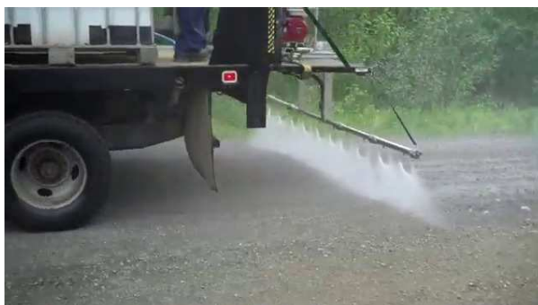
Figura 2-6 Esempio di bagnatura di terreni a mezzo di autocisterna
